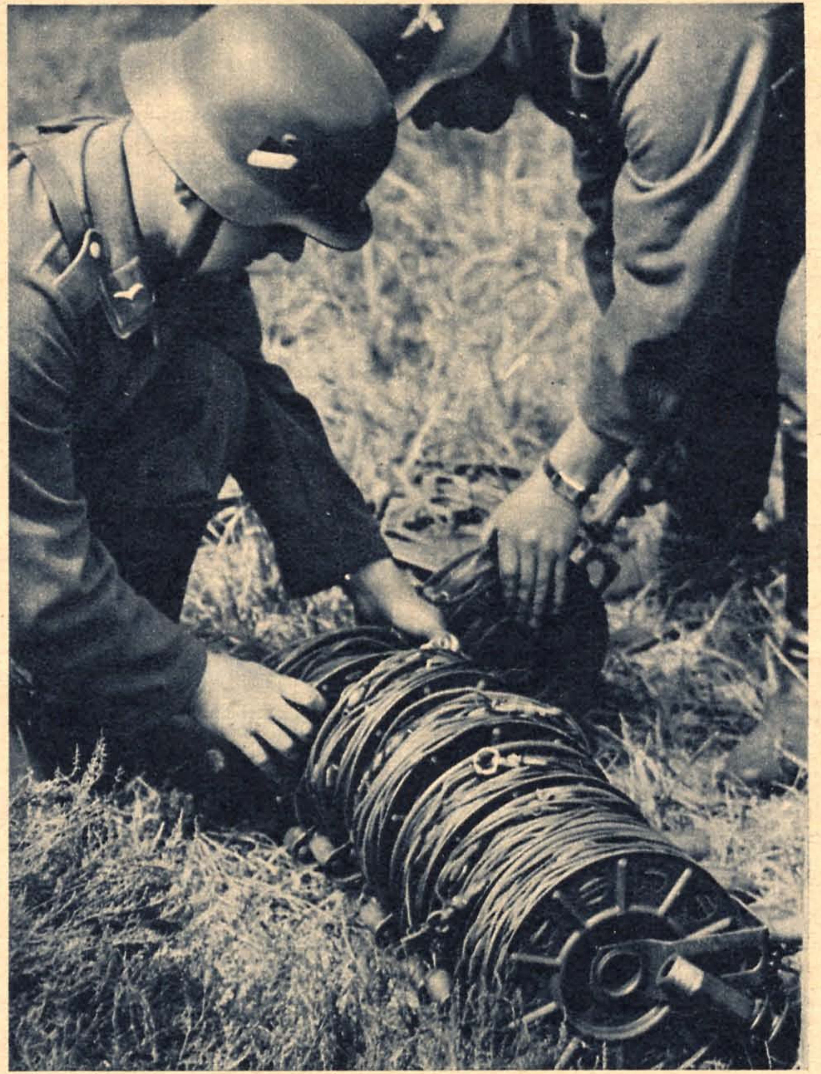
Sorgfältig werden die Kabel aufgerollt, um sie vor Beschädigungen zu schützen und ihren schnellen Bau am neuen Einsatzort zu gewährleisten
